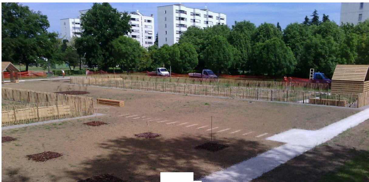
Réalisation du projet, Giardino Impastato
